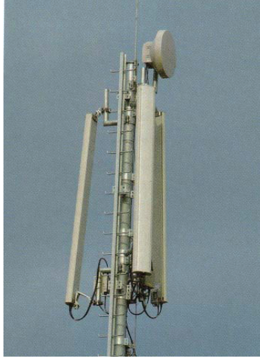
Şekil 10.7: Bir baz istasyonunun 120 derece açılarla, 3 bölgeye doğru yönlendirilmiş sektörel antenleri
