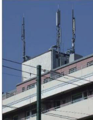
Şek.10.12 ve 10.13: Çatılardaki baz istasyonlarına örnekler
