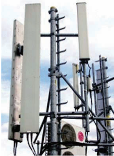
Şek.10.12 ve 10.13: Çatılardaki baz istasyonlarına örnekler
