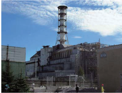
Şekil 6.1 Çernobil santralına kalın duvar örülmesi (kapsüllemesi)
